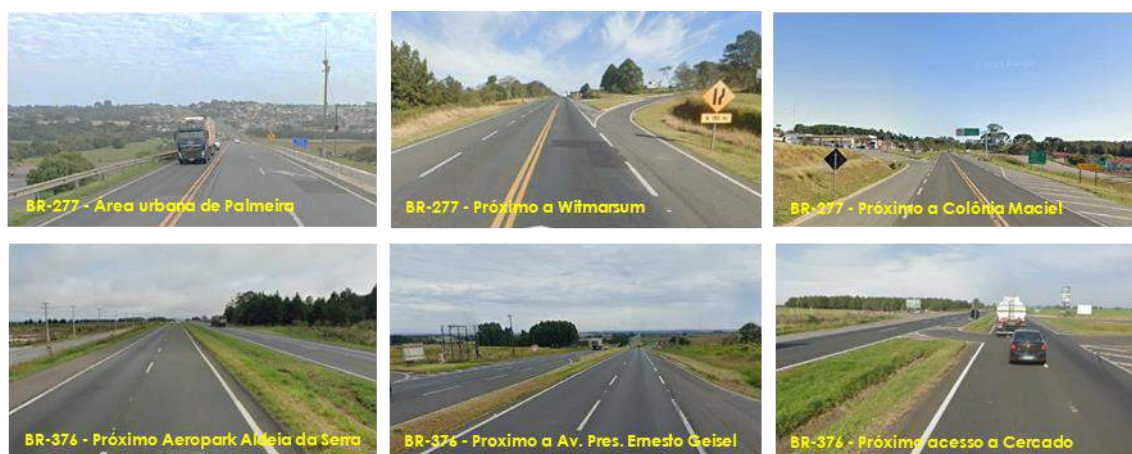
Figura 158: Aspectos da pavimentação nas rodovias federais
