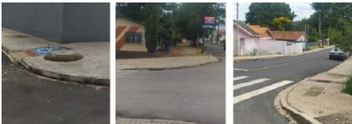
Figura 78: Exemplos de Rampas que não seguem os parâmetros exigidos pela NBR 9050/2020
