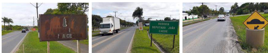
Figura 159: Aspectos da pavimentação na rodovia estadual
