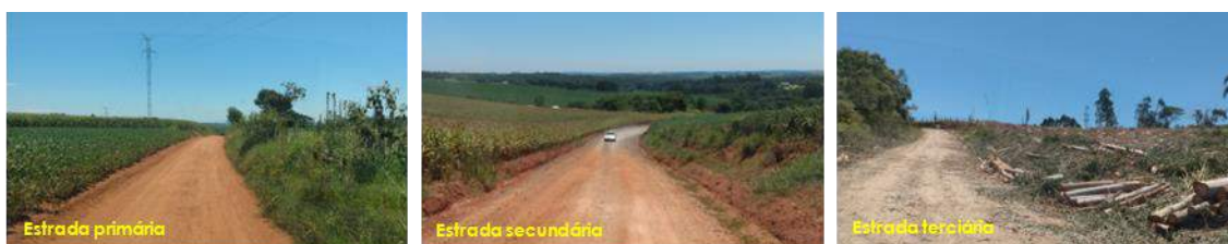
Figura 160: Aspectos da pavimentação de estradas rurais
