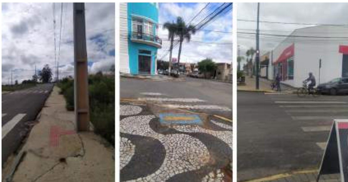
Figura 79: Rampas que atendem a NBR 9050/2020 mas não atendem o Estatuto do Idoso e Deficiente
