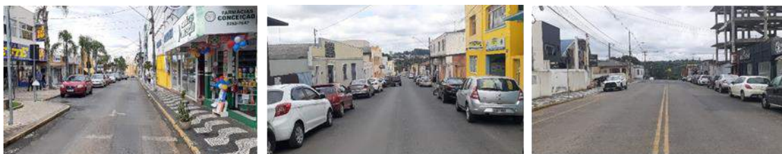
Figura 154: Aspectos da pavimentação urbana da Sede
